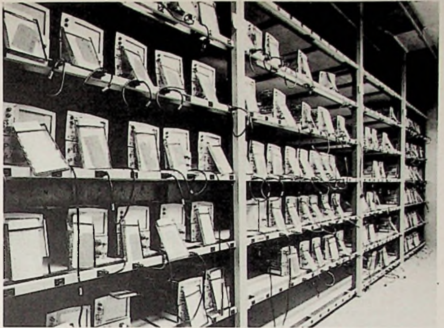
Beproeving van de oscilloscopen in een klimaatkamer.
